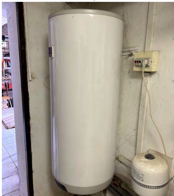
Obrázek č. 2.6.59: Zásobníkový ohřívač TV
