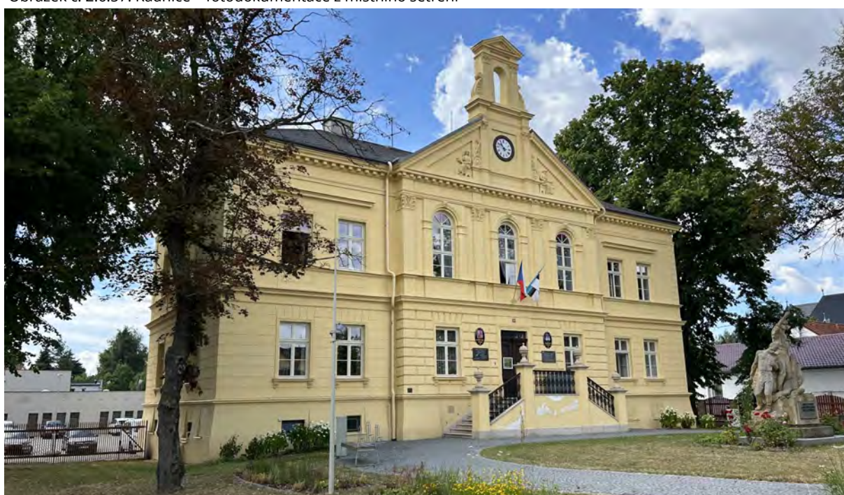
Obrázek č. 2.6.57: Radnice – fotodokumentace z místního šetření
