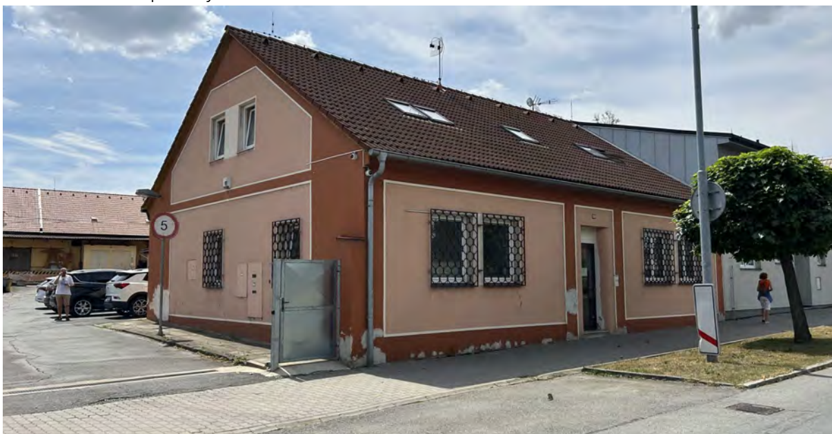
Obrázek č. 2.6.3: Hospodářský dvůr - administrativní budova – fotodokumentace z místního šetření
