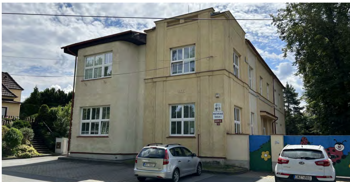
Obrázek č. 2.6.23: Mateřská škola ul. Husova – fotodokumentace z místního šetření
