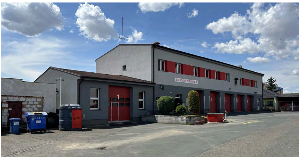
Obrázek č. 2.6.42: Požární zbrojnice – fotodokumentace z místního šetření
