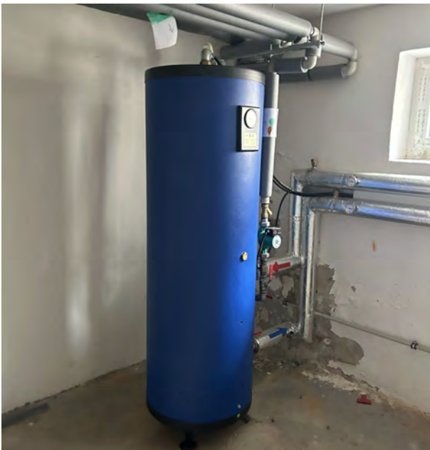
Obrázek č. 2.6.21: Nepřímotopný zásobníkový ohřívač TV
