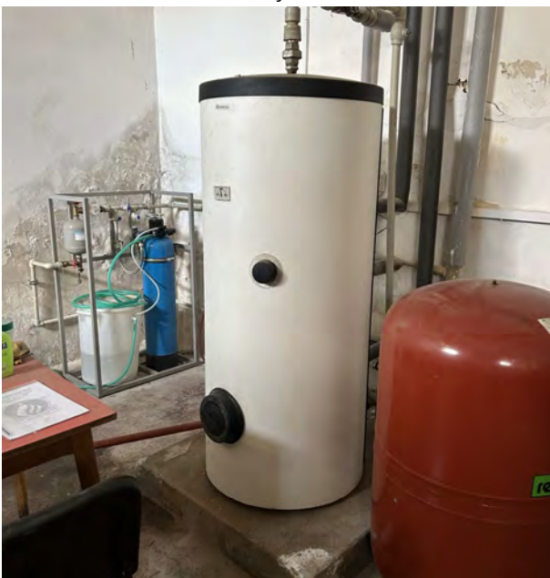
Obrázek č. 2.6.34: Zásobníkový ohřívač TV
