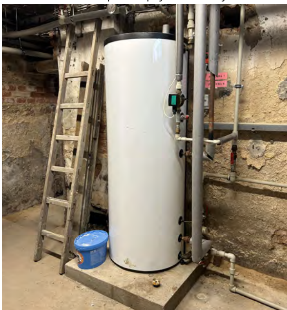
Obrázek č. 2.6.47: Nepřímotopný zásobníkový ohřívač TV
