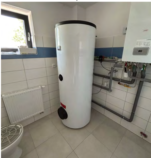
Obrázek č. 2.6.63: Zásobníkový ohřivač TV
