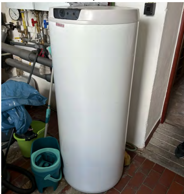
Obrázek č. 2.6.44: Zásobníkový ohříváč TV
