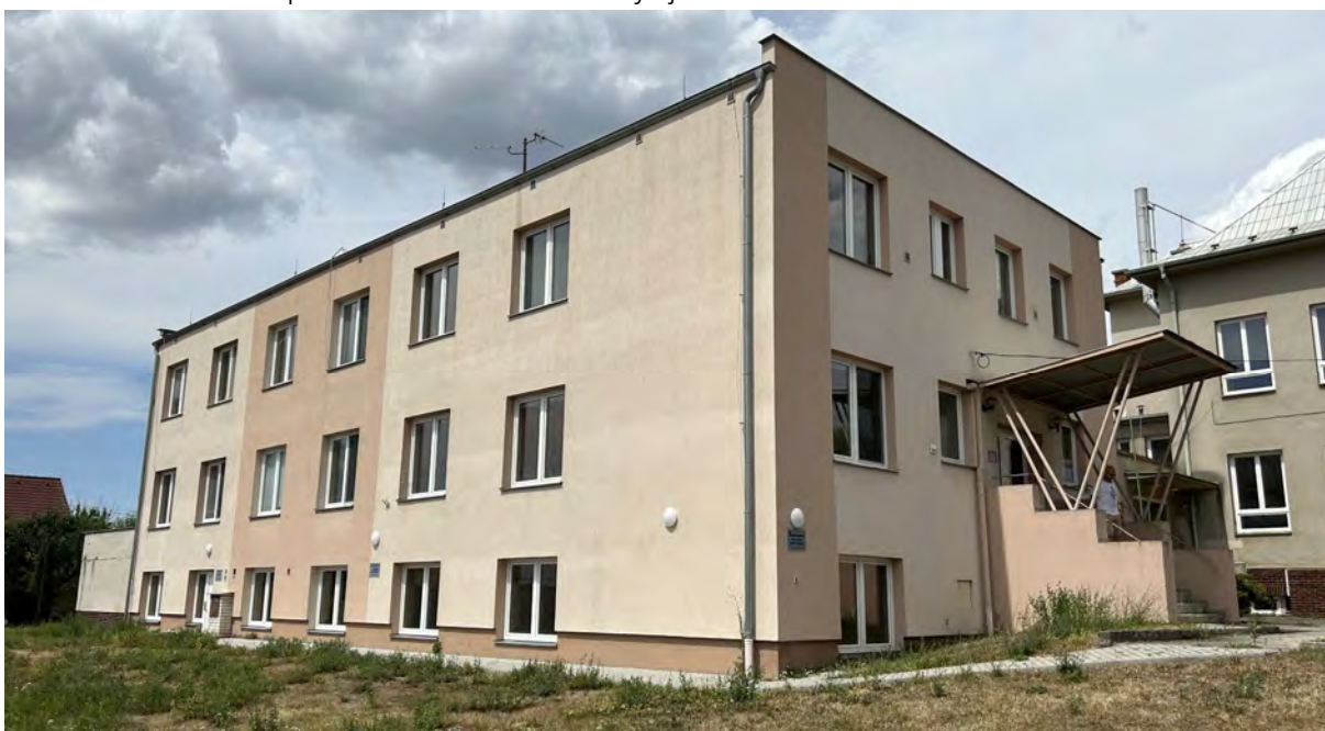
Obrázek č. 2.6.19: Dům s pečovatelskou službou Kamenný Újezd – fotodokumentace z místního šetření
