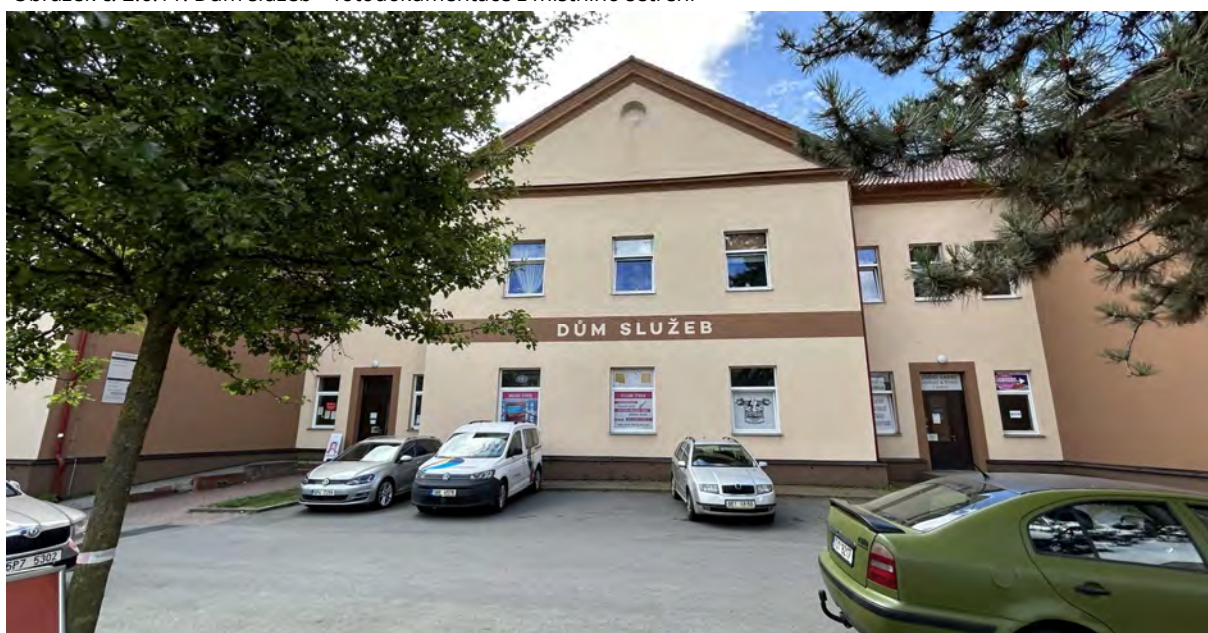
Obrázek č. 2.6.11: Dům služeb – fotodokumentace z místního šetření
