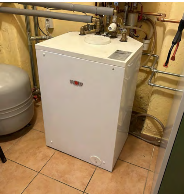
Obrázek č. 2.6.5: Nepřímotopný zásobníkový ohřívač TV
