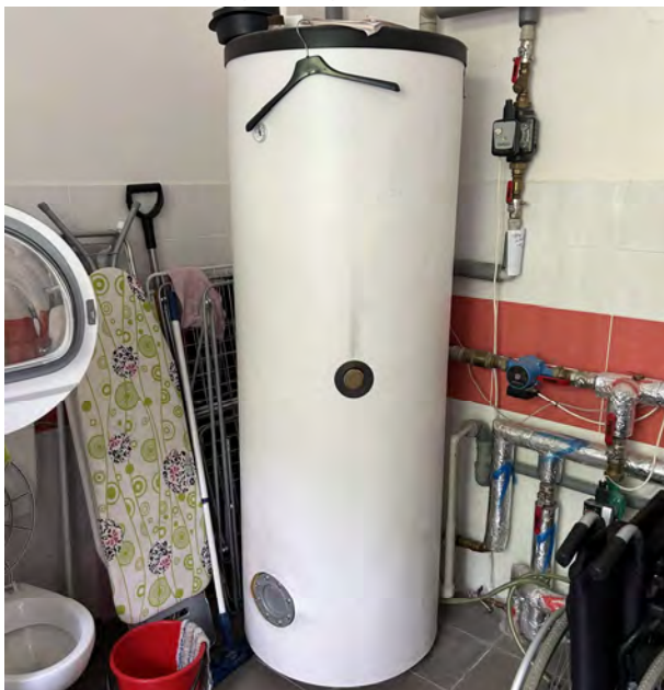
Obrázek č. 2.6.17: Nepřímotopný zásobníkový ohřívač TV
