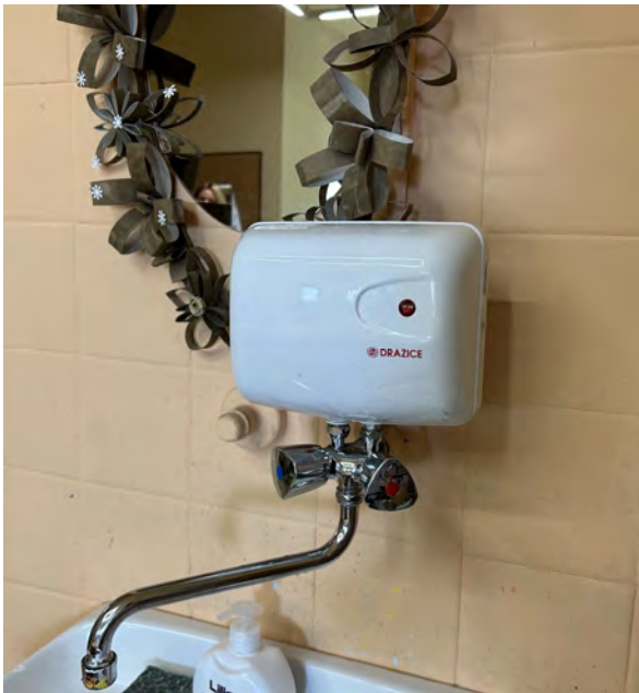
Obrázek č. 2.6.40: Průtokový ohřívač TV
