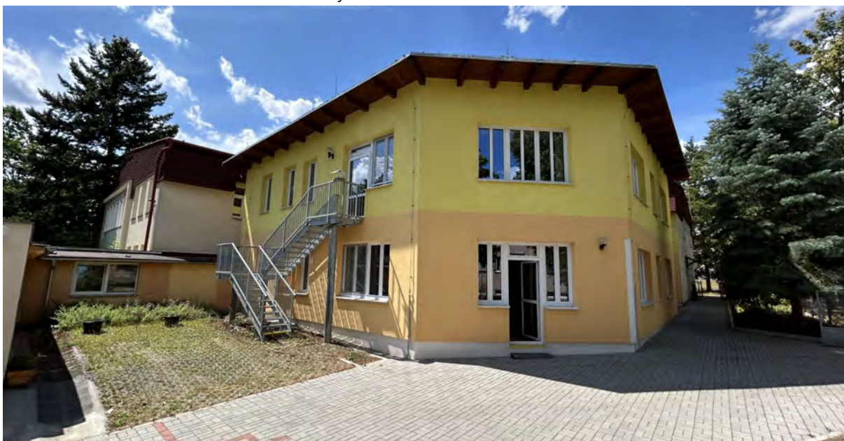
Obrázek č. 2.6.27: Mateřská škola ul. K. H. Máchy – fotodokumentace z místního šetření
