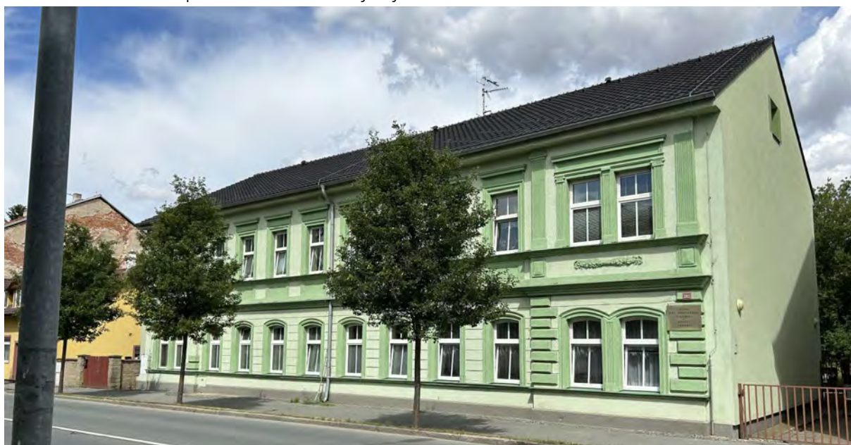
Obrázek č. 2.6.15: Dům s pečovatelskou službou Nýřany – fotodokumentace z místního šetření
