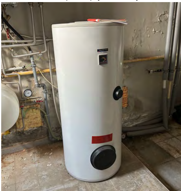
Obrázek č. 2.6.55: Nepřímotopný zásobníkový ohříváč TV
