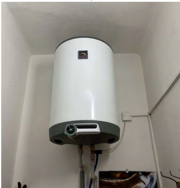
Obrázek č. 2.6.25: Zásobníkový ohříváč TV
