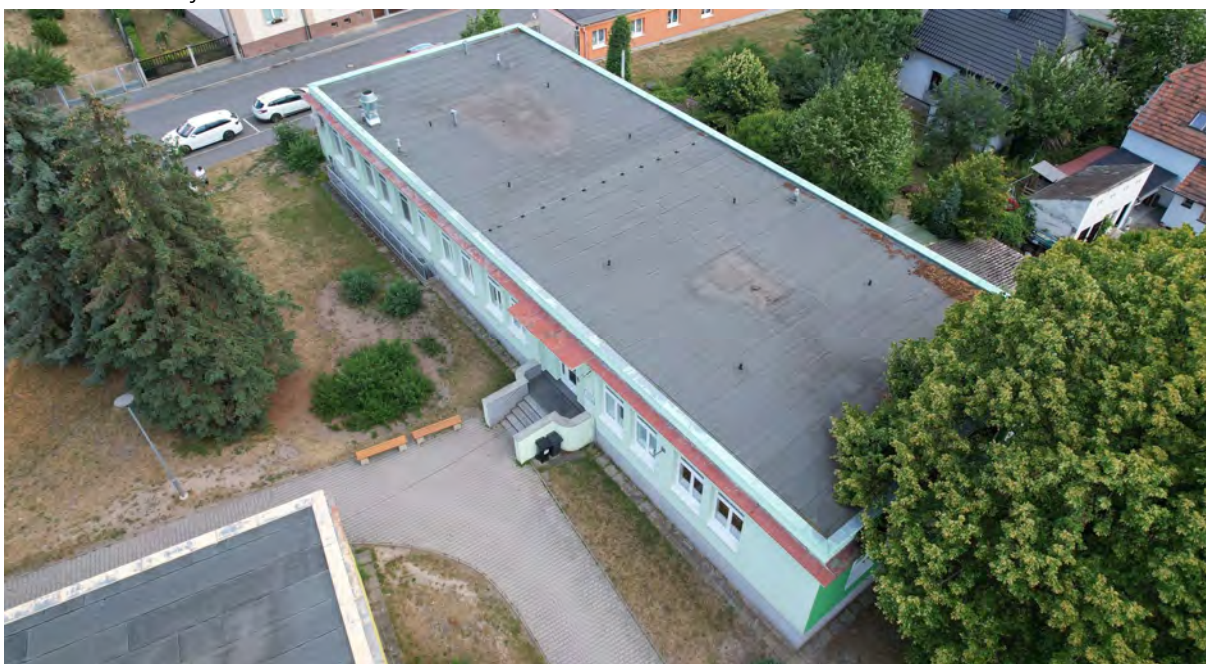
Obrázek č. 2.6.36: Jídelna ZŠ – fotodokumentace z místního šetření
