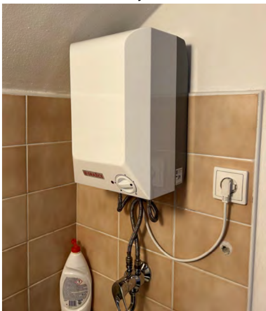
Obrázek č. 2.6.6: Průtokový ohřívač TV
