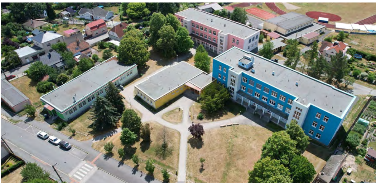
Obrázek č. 2.6.32: Základní škola – fotodokumentace z místního šetření
