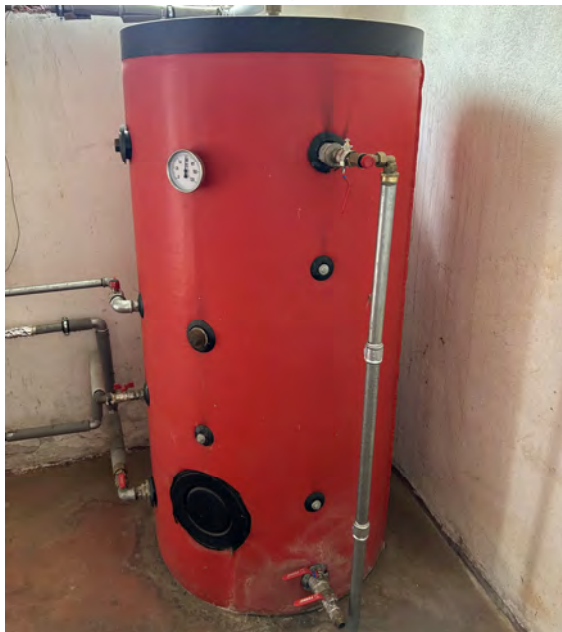
Obrázek č. 2.6.51: Nepřímotopný zásobníkový ohříváč TV
