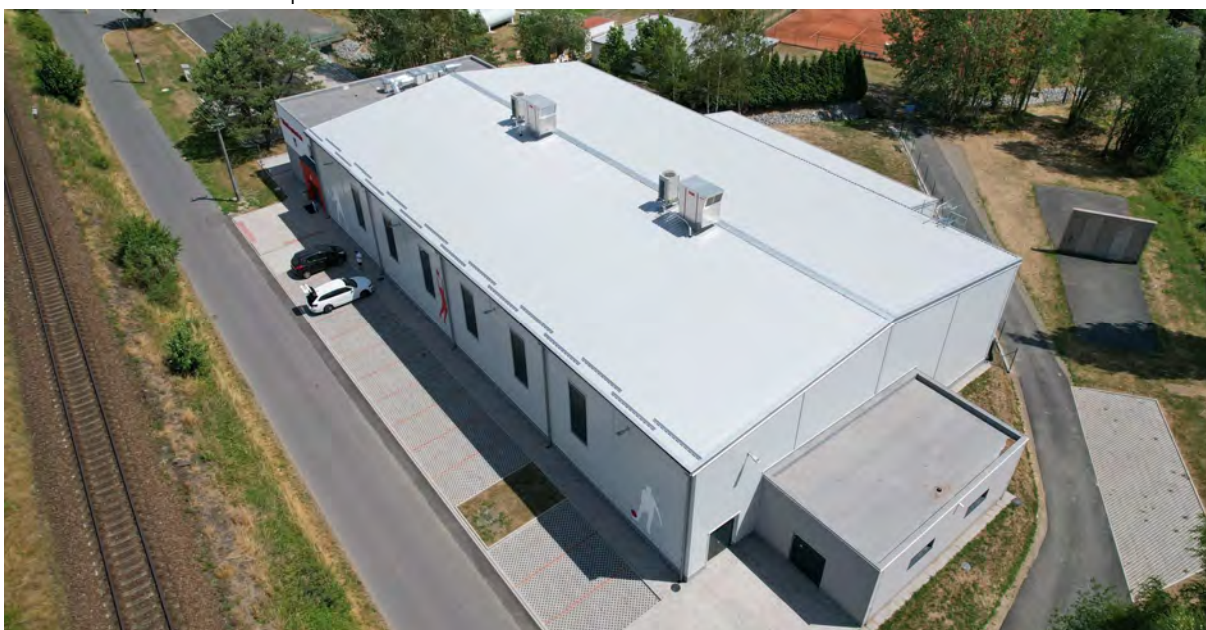
Obrázek č. 2.6.61: Městská sportovní hala – fotodokumentace z místního šetření
